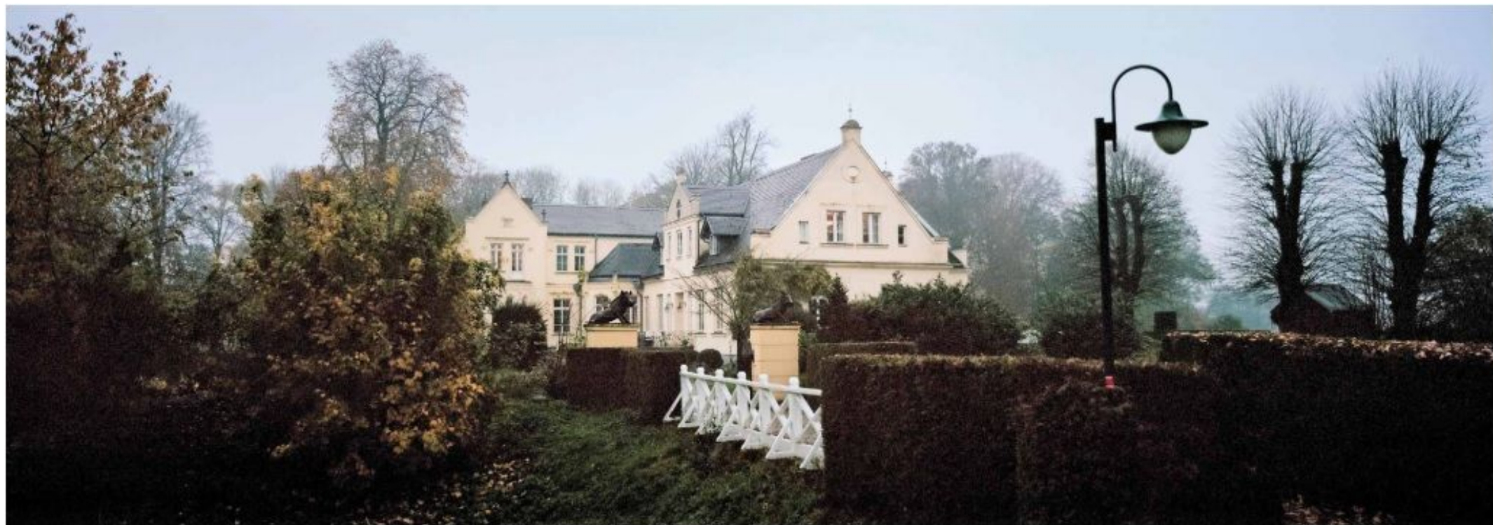
Das Gutshaus in Dabitz erzählt die typische Geschichte eines Herrenhauses: Ursprünglich war es eine Raubritterburg, heute ist es das Hauptgebäude eines großen Landwirtschaftsbetriebs.
